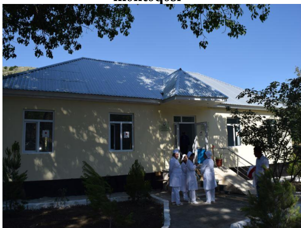
Layihə çərçivəsində inşa olunan tibb məntəqəsi
